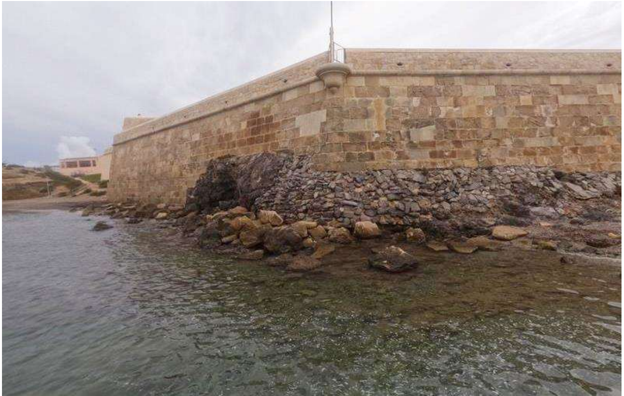
Fotografía 3-20. Aspecto de la muralla en la cara norte, con grandes bloques de escollera.
