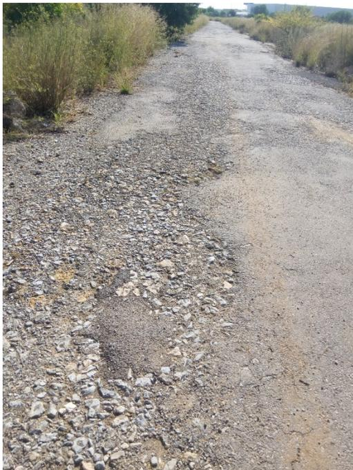
Disgregación del firme asfáltico
