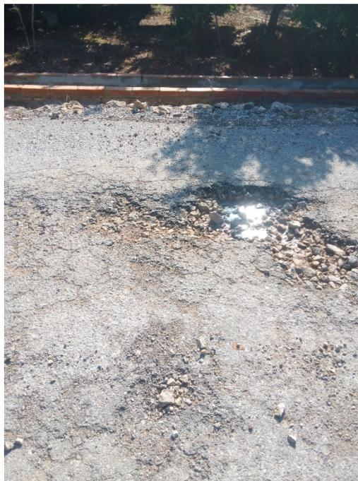
Fisuración y disgregación de la capa de rodadura
