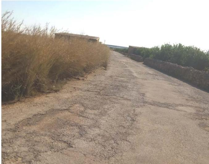
Deformaciones y degradación del firme
