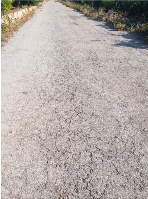
Rotura en forma de piel de cocodrilo debida a fallos en la capacidad portante de la base granular
