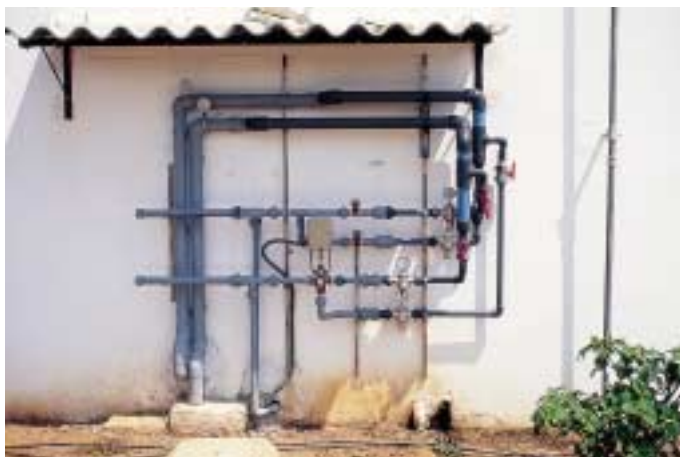
20. Sistema de mezcla automático a partir de la medida de conductividad eléctrica, agua de lluvia y agua de pozo. Fundación Caja Rural Valencia.
