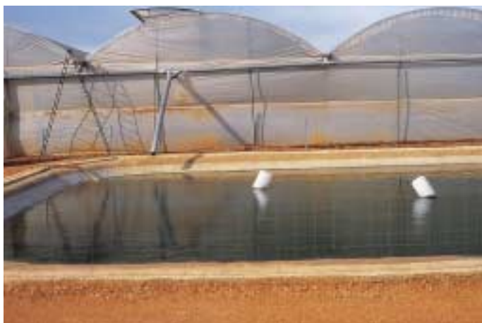
19. Canalización del agua de lluvia a la balsa de riego.
