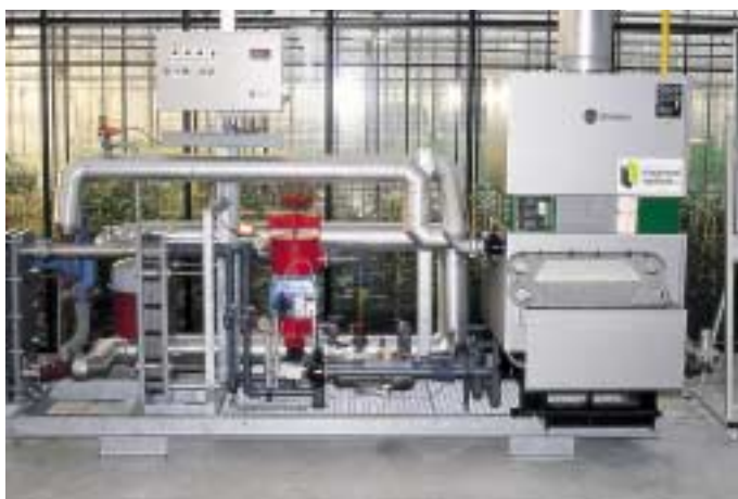
49. Desinfección de drenaje por Termodesinfección
