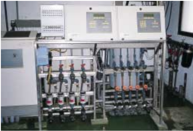
22. Ordenador de riego con ajuste automático del pH y de la CE. Fundación Caja Rural Valencia.
