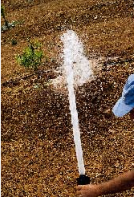
Foto 5. Limpieza de finales de tubería.
