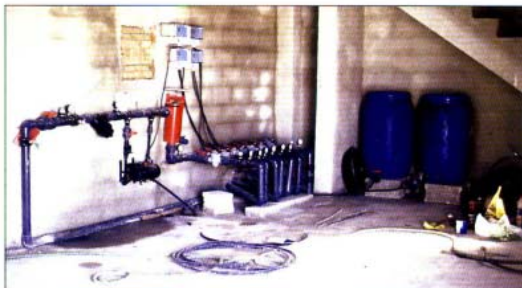
Inyección mediante bomba hidráulica.
