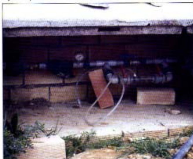
Inyección por el medio de venturi.
