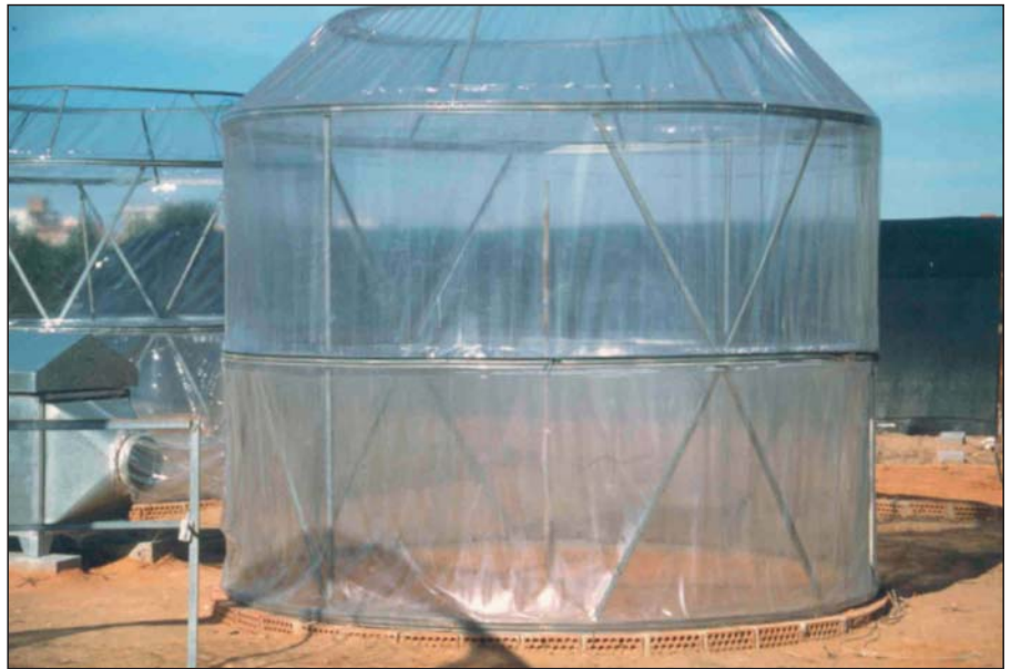
Foto D. Cámara abierta completada su instalación.
