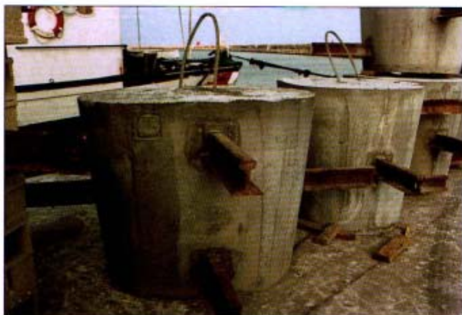
Módulo de arrecife de protección truncocónico de 3,6 Tm. a bordo del barco.
