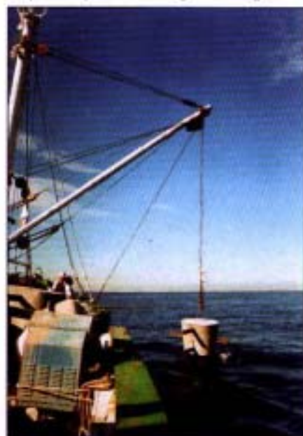
Módulo de arrecife truncocónico de 3,6 Tm. suspendido para ser sumergido en el agua.
