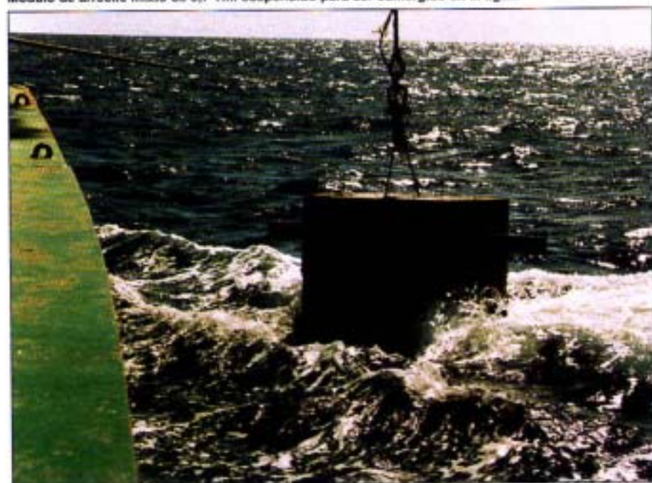
Módulo de arrecife mixto de 3,7 Tm. suspendido para ser sumergido en el agua.
