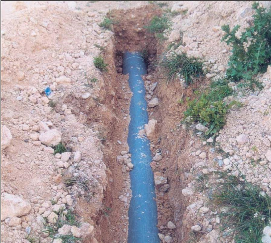
**Foto 4.** Tubería de PVC de 200 mm de diámetro nominal. Insuficientemente enterrada. Se aprecian piedras de cierto tamaño sobre la generatriz superior del tubo. En menos de un año hubo de ser sustituida por rotura al no soportar el tránsito de vehículos.
