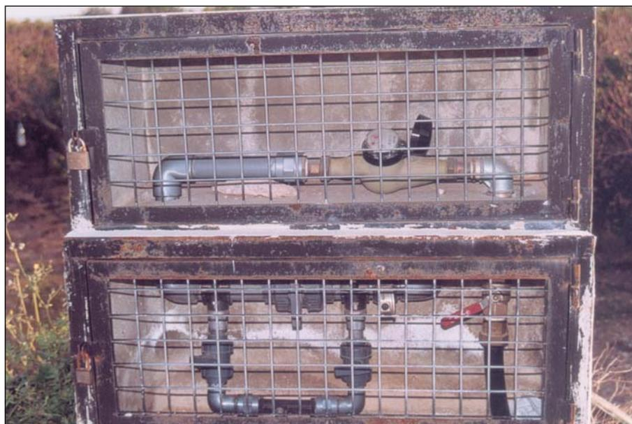
Foto 2. Toma individual con contador y venturi para la inyección de fertilizantes.
