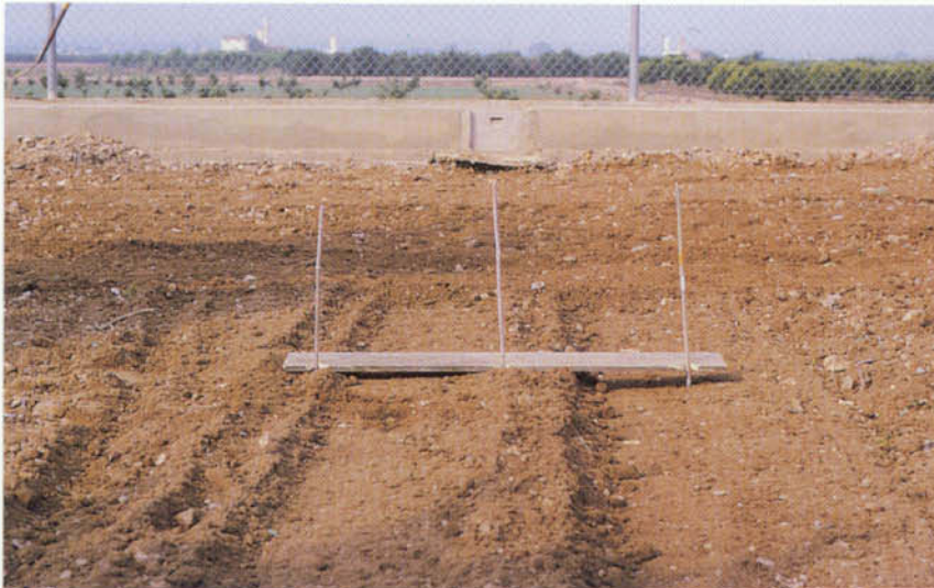
Foto 9.- Instalación de referencias con ayuda de tabla de plantar.
