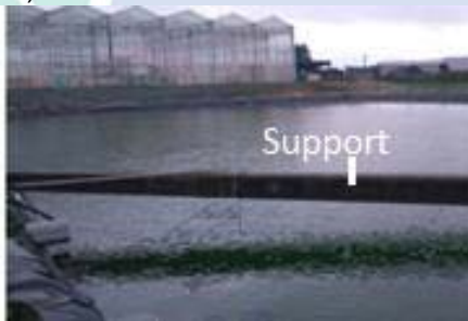
Figura 8: Exemples de diferents configuracions de bombes flotants. a) i b): bombes fixades a flotadors; c): bomba flotant subjecta a una estructura fixa, en aquest cas a un pal (font: CATE).
