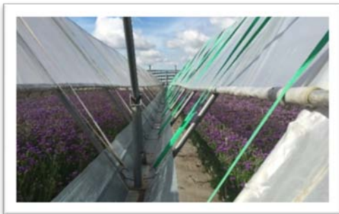
Túnel de diversos trams equipat amb canals i ventilació per a la recollida d'aigües pluvials.
