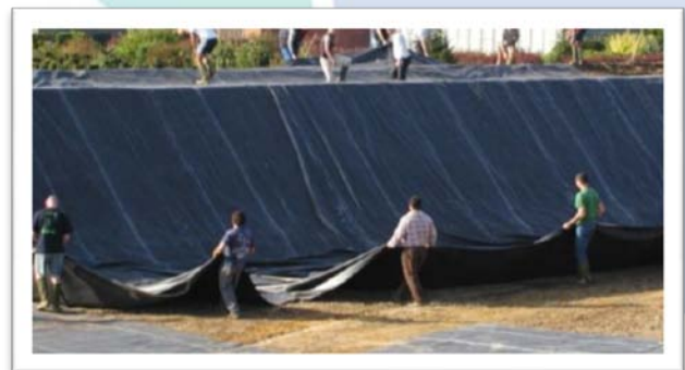
Instalando de una lámina en una balsa de agua.
