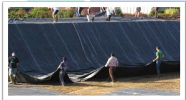
Instal·lant la làmina en el dipòsit d'aigua.
