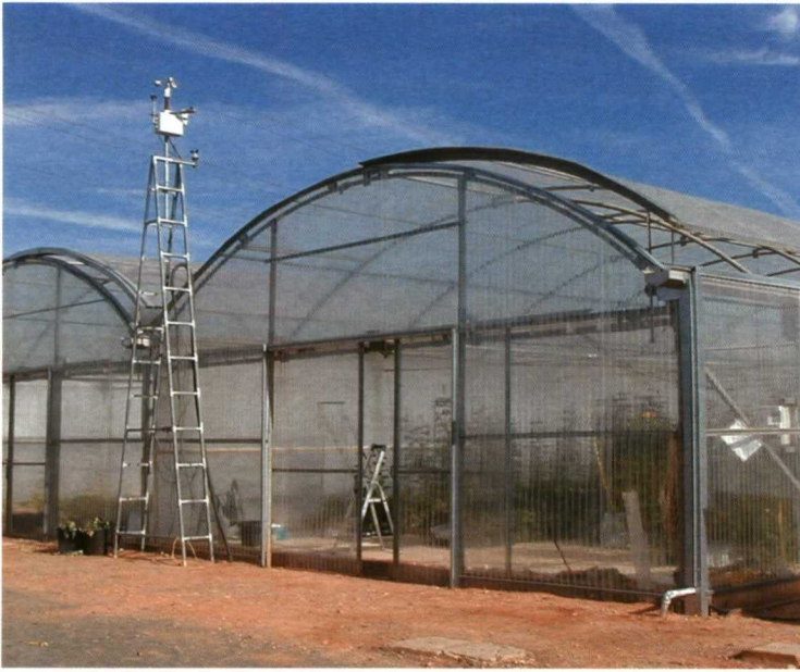
El invernadero utilizado para los ensayos es de policarbonato equipado con ventilación cenital, nebulización de alta presión, calefacción por aerotermos y radicular, y un conjunto de sensores.
