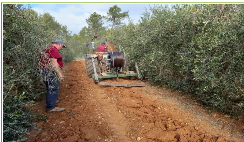
Imatge d'olivar intensiu instal·lant reg localitzat subterrani a Enguera. Font: OCA d'Enguera i la Canal.
