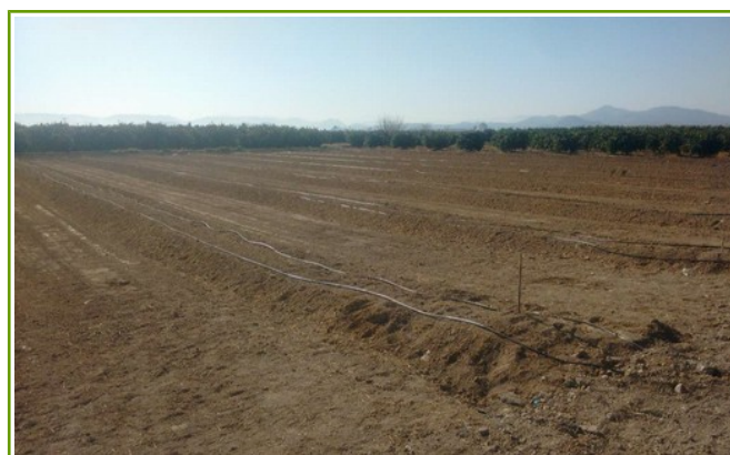
Acondicionamiento del terreno e instalación de riego localizado. Fuente Oca Ribera Alta-Alzira
