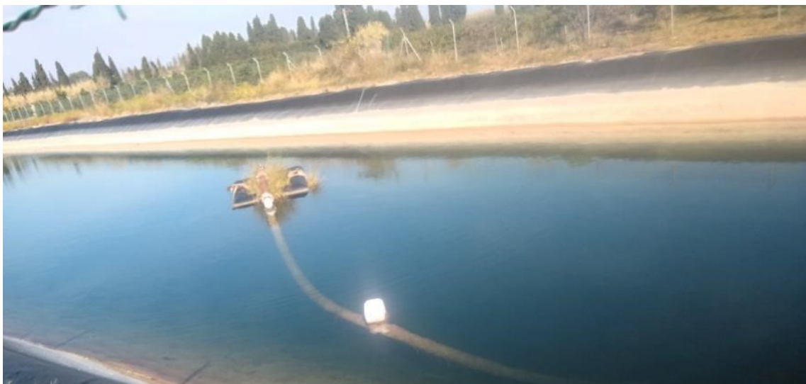
Imagen 2. Balsa de riego. Les Alqueríes de Santa Barbara. Burriana &
